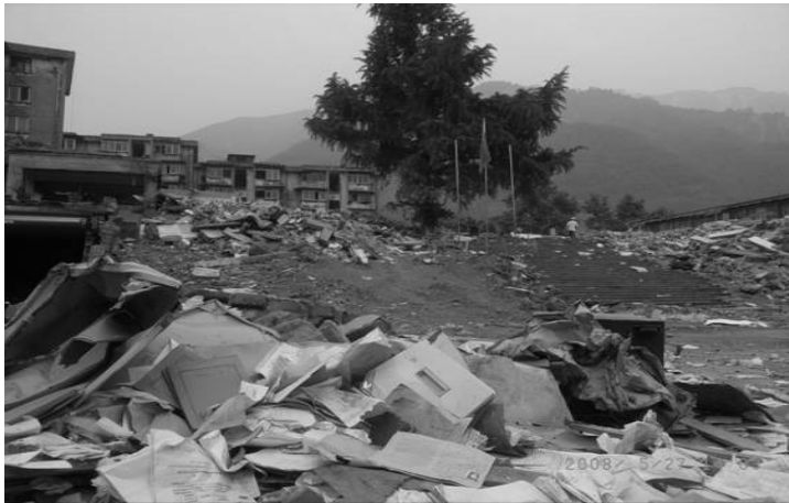
図 6-2-2 倒壊した漢旺鎮庁舎（綿竹市漢旺鎮）
