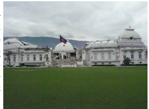
【倒壊した大統領宮殿】 (2階部分は完全に潰れている)
