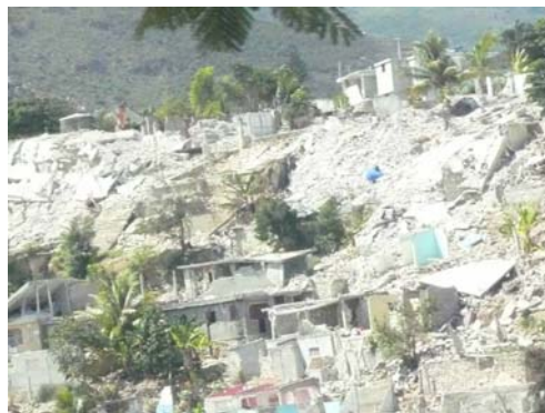
[ポルトープランスの郊外の傾斜地の倒壊した住居群]
