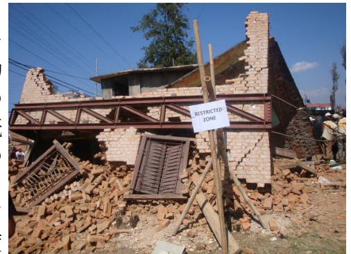
【第一回の実験：耐震補強をしていない建物】
