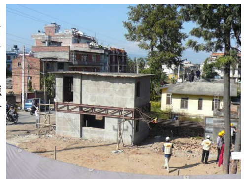
【第二回の実験：耐震補強をした建物】
