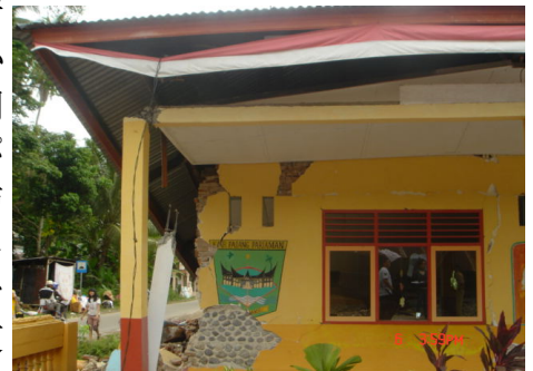
[学校の被害場]
