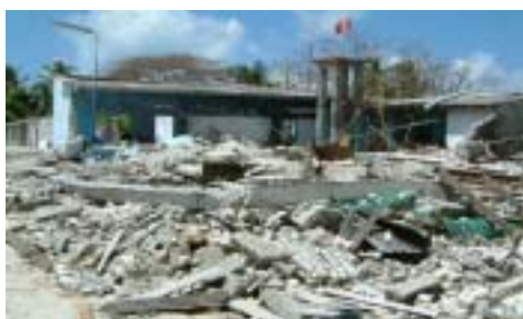
ター環礁ヴィルフシ島の倒壊建物
