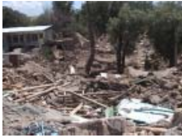
地震により全壊したビル (震源近くのチャングレー地域)
