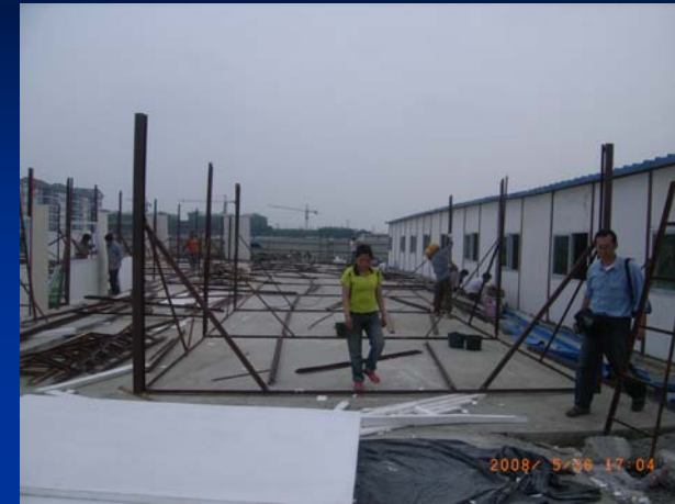
【建設中の仮設住宅(都江堰市)】
