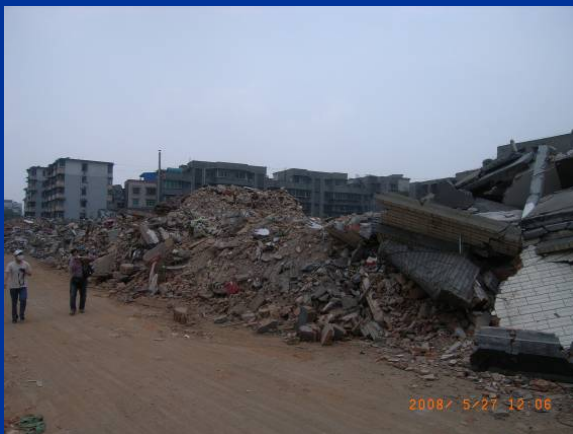
【漢旺鎮の被害状況】
