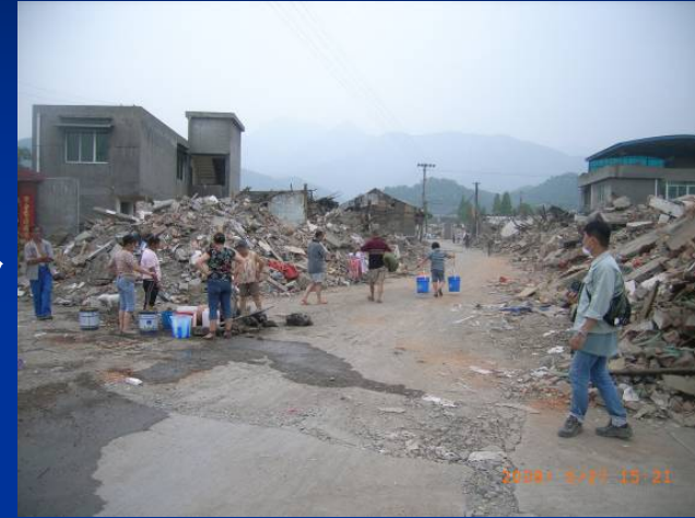
【古い住宅が倒壊】
