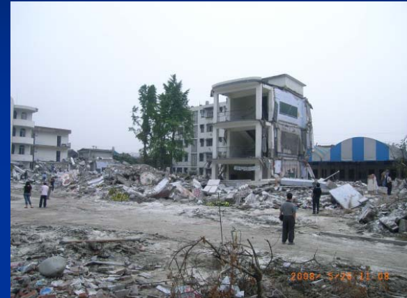
【被害の大きかった聚源中学校】
