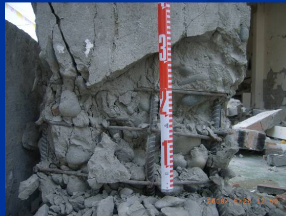
【座屈した鉄筋コンクリート柱】
