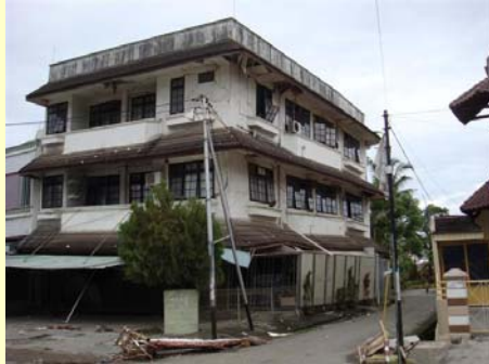
壁等にクラックが入り傾いているビル (パダン市内 10月5日)
