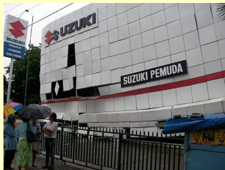
ショールームの1階がつぶれた様子 (パダン市内 10月1日)
