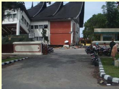
1階部が潰れた公的施設 大きな屋根構造が特徴的 (パダン市内 10月5日)
