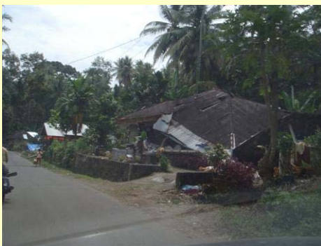
全壊した平屋建ての民家 屋根部は軽量だがレンガの壁が崩れてしまった。 (パリアマン市内 10月6日)
