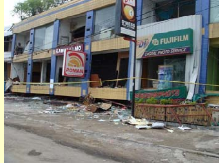
商業ビル1階の駐車場部がつぶれている (パダン市内 10月5日)
