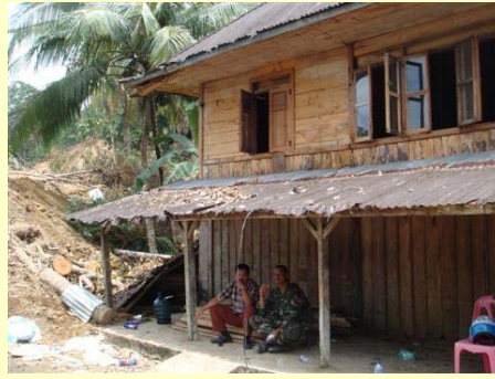
土石流の難を間一髪逃れた建物 (パダンパリアマン県内 10月7日)
