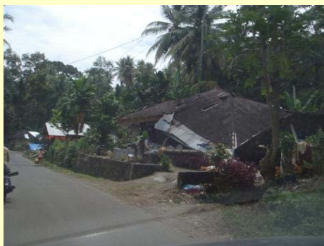
土石流の発生した地区の近くの倒壊した民家 (パダンパリアマン県内 10月7日)
