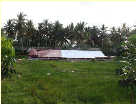
全壊した中学校 屋根は木杵とトタンで軽量だが、 柱が細くて本数が少ない。 (パダンパリアマン県内 10月6日)
