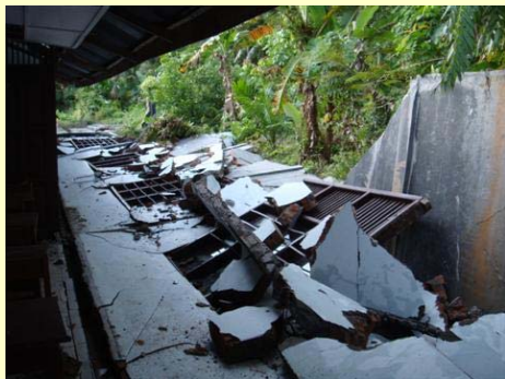
壁が崩れた中学校 柱と梁に鉄筋は入っているが 鉄筋が接合されていない。 (パダンパリアマン県内 10月6日)
