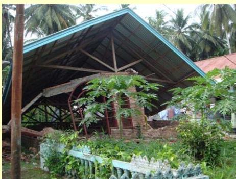
レンガの壁の崩壊による建物の倒壊 (パリアマン市内 10月6日)
