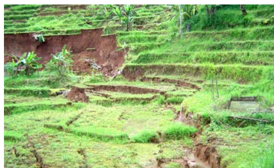
崩落開始部分高さ 3m 西ジャワ州チアミス地方シトゥマンダラ村の水田
