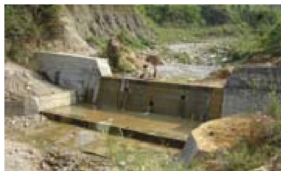
写真 2：Khahare Khola 砂防ダム（ch 0+220）
