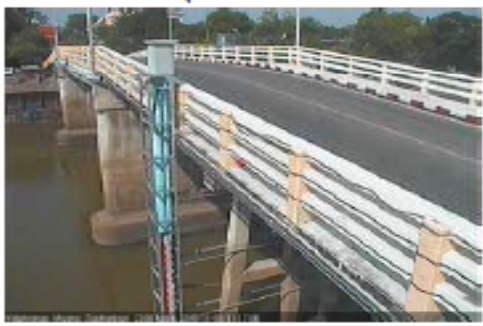
สะพานวัดพระรูป อ.เมือง จ.สุพรรณบุรี (ลุ่มน้ำท่าจีน)
