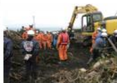
消防団による重機を活用した活動支援 (平成25年台風25号による伊豆大島の災害) 写真提供:横浜消防局 Support by fire corps using heavy equipment (Photo:Yokohama City Fire Department)
